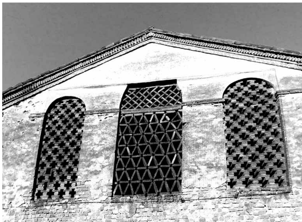
Fig. 19: Trafori in laterizio del fienile sopra lo stallone
