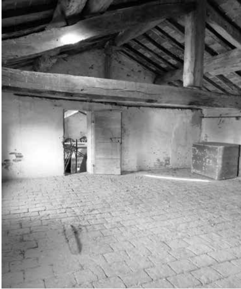
Fig. 20: Tetto a capriate nel solaio
